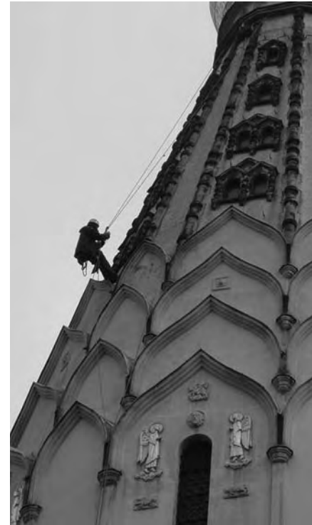
Bild 7: Seilunterstützte Arbeits- und Zugangsverfahren
