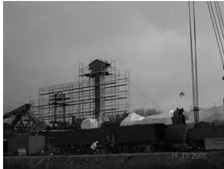
Bild 4: Arbeits- und Schutzgerüste
