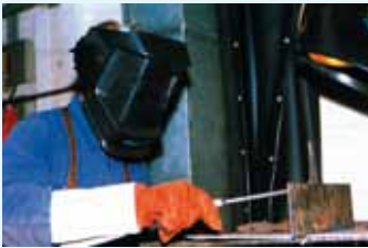
Schlacke entfernen mit einem selbstabdunkelnden Schweißerschutzschirm
