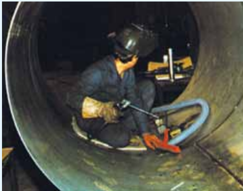
Schweißer auf einer isolierenden Unterlage in einem Behälter
