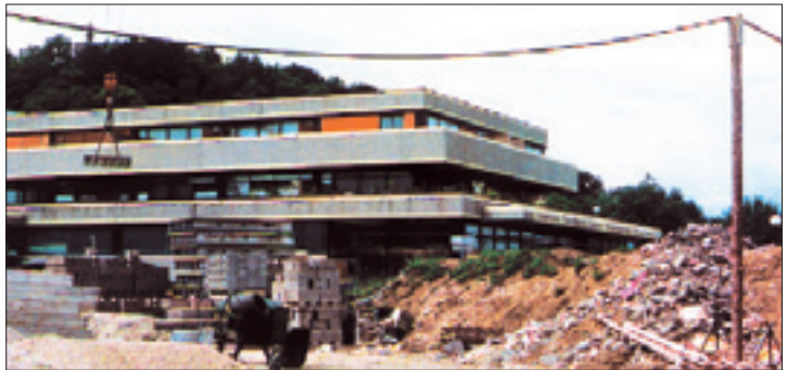
Hoch gehängte Zuleitung
