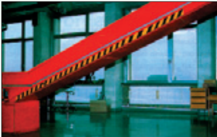
Beispiel eines gut gesicherten Durchganges unter einem Förderband
