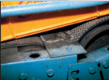
Gesicherte Gefahrenstelle zwischen zwei Förderbändern
