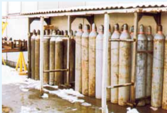
Flaschenlager: Gasflaschen mit verschiedenen Gasen sowie gefüllte und leere Flaschen müssen getrennt voneinander gelagert werden
