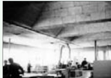
Tischlerei-Hallendecke, 50 mm starke Glaswollemat- ten hinter Holzlattung verlegt
