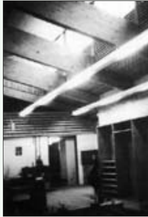
Tischlerei-Hallendecke, 50 mm starke Glaswollemat- ten hinter Holzlattung verlegt
