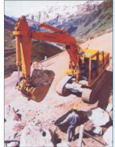
Der Aufenthalt im Gefahrenbereich ist verboten!
