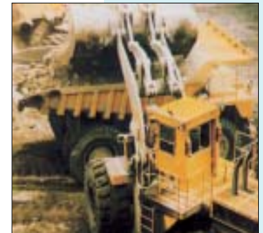
Der Maschinenführer darf die Arbeitseinrichtung über den Fahrer nur hinwegschwenken, wenn dieser durch ein Schutzdach gesichert ist
