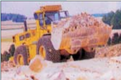
Fahrstraßen müssen ausreichend breit, mit möglichst geringem Gefälle und auf tragfähigem Untergrund angelegt sein
